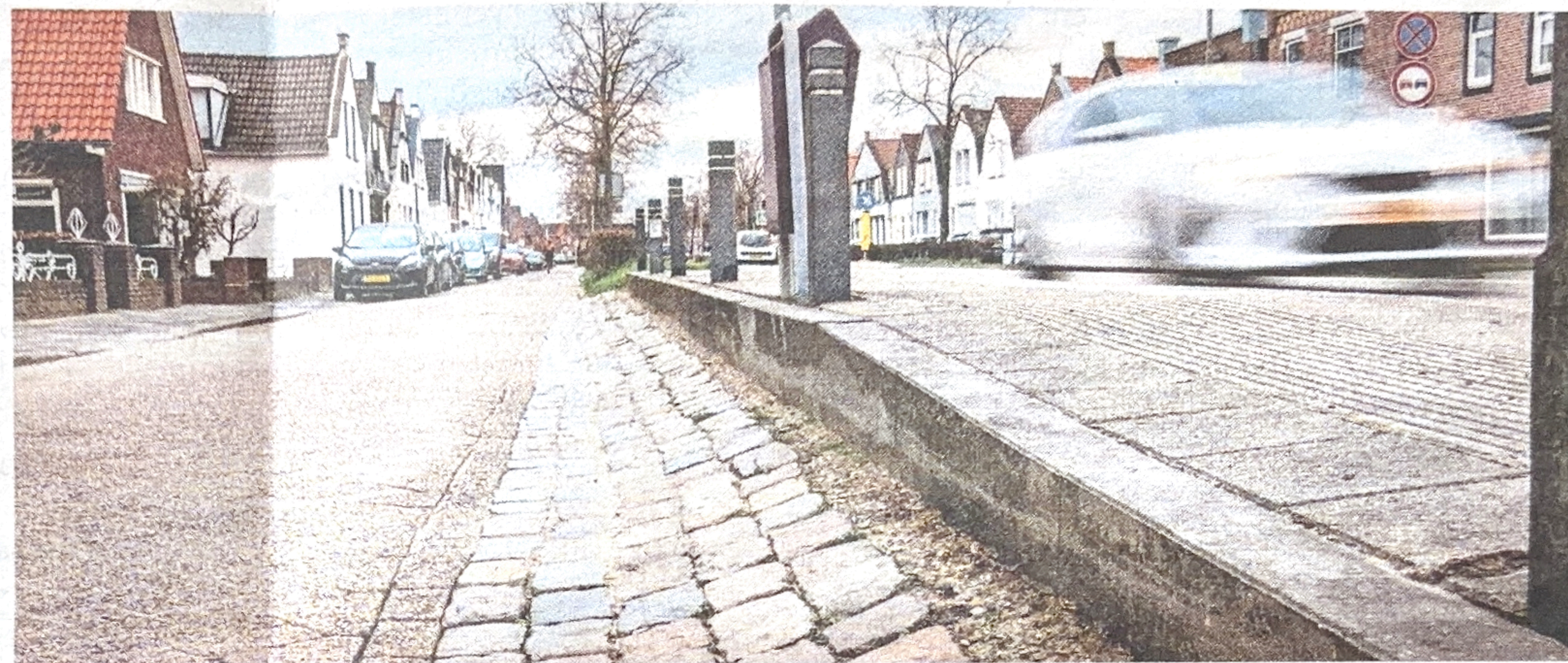
▲ De Steenbergseweg in Dinteloord is aan vervanging toe. Daar wordt ook al jaren over gesproken. Het is de bedoeling dat het werk komend najaar ook daadwerkelijk gaat beginnen. ARCHIEFFOTO MARCEL OTTERSPEER/
